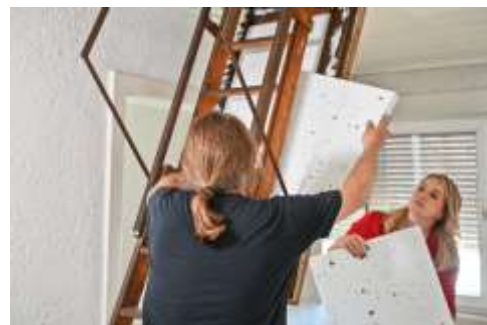
Abbildung 8: Einpuzzeln der zweiten Dämmschicht.
