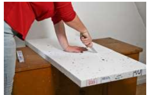
Abbildung 5: Platte mit dem Brotmesser schneiden.
