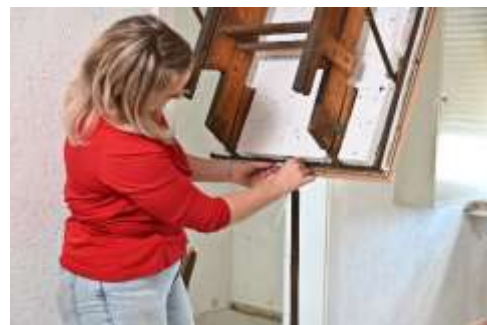
Abbildung 9: Schaumstoffdichtband aufkleben.
