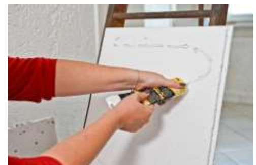
Abbildung 6: Aufbringen des Montageklebers.
