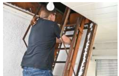
Abbildung 7: Die erste Dämmlage ist zwischen die Rahmenhölzer eingeklebt. Der Kleber für die 2. Schicht ist schon auf dem Rahmen und wird gerade zusätzlich auf die erste Dämmlage aufgetragen.
