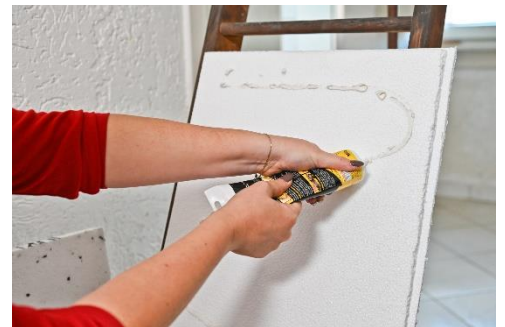
Abbildung 6: Aufbringen des Montageklebers.
