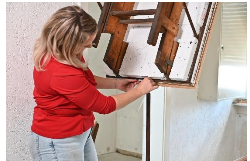
Abbildung 9: Schaumstoffdichtband aufkleben.
