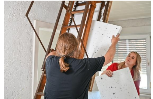
Abbildung 8: Einpuzzeln der zweiten Dämmschicht. Denke gegebenenfalls an den normgerechten Abstand von 10 cm zwischen Stufenmitte und Dämmstoff.
