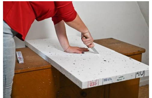
Abbildung 5: Platte mit dem Brotmesser schneiden.
