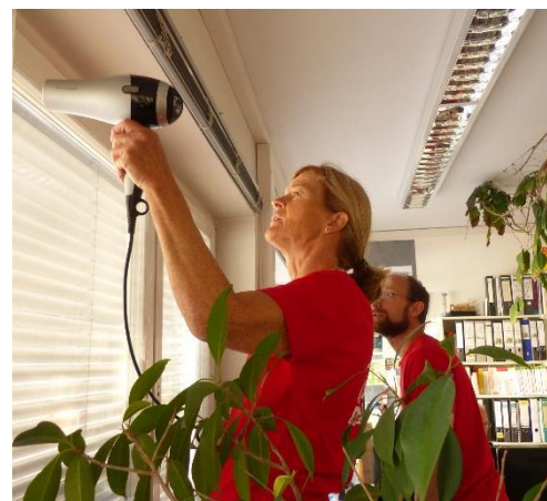
Abbildung 6: Durch das Föhnen strafft sich die Folie.
