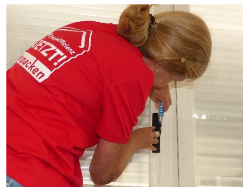
Abbildung 7: Überstehende Folie abschneiden.
