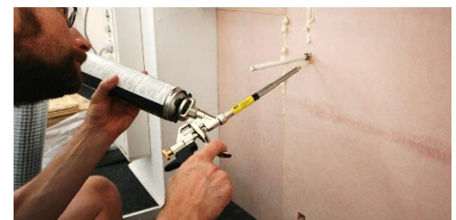
Abbildung 12: Ausschäumen der Fugen.
