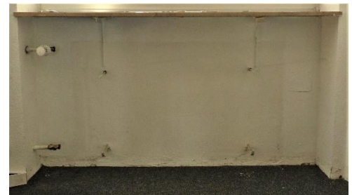
Abbildung 5: Der Heizkörper ist abmontiert.
