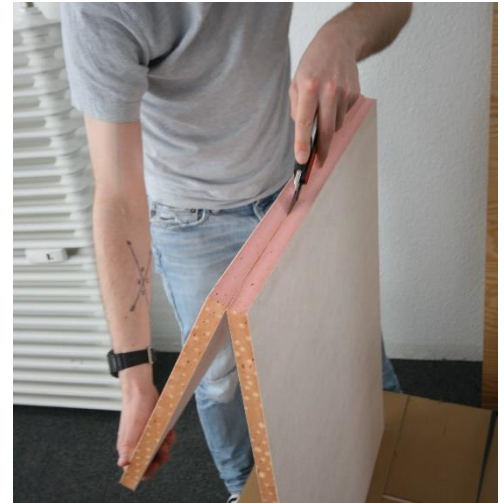
Abbildung 9: Trennen der Vlieskaschierung.
