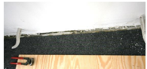
Abbildung 6: Die Lücke zwischen Estrich und Wand muss luftdicht abgeklebt werden.
