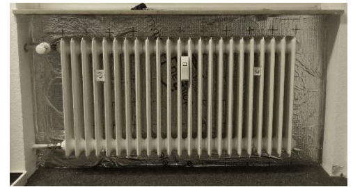
Abbildung 16: Die fertig gedämmte Heizkörpernische: Der Winter kann kommen.
