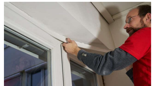
Abbildung 3: Laibungsleisten entfernen.
