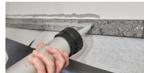
Abbildung 10: Dichtkleberraupe auf Dämmstoffplatte und Wand ziehen.
