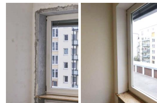
Abbildung 12: Fertig angebracht und gestrichen.
