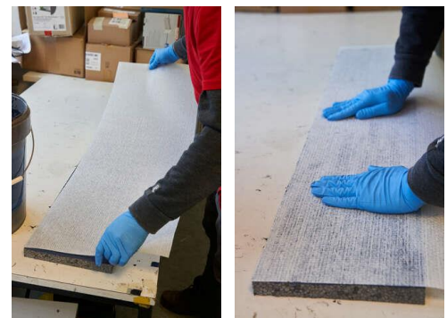
Abbildung 5: Glasfasertapete in die nasse Abdichtung einlegen und anreiben.
