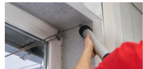
Abbildung 9: Ecken verfugen.
