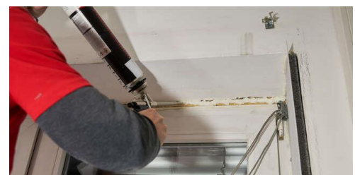
Abbildung 7: Fugen mit PU-Schaum füllen.
