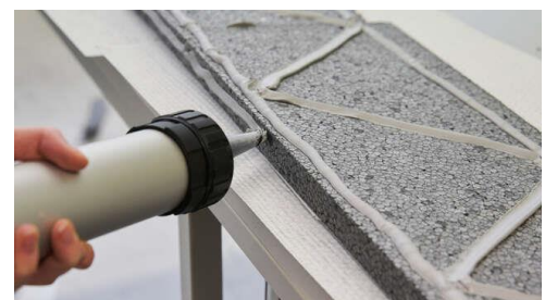
Abbildung 6: Dichtkleber aufbringen.
