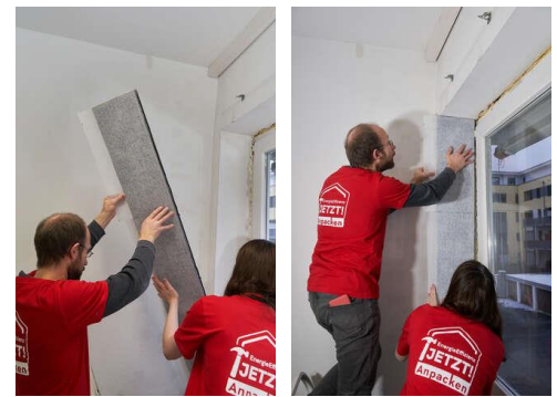
Abbildung 8: Laibungsplatten setzen und sorgfältig andrücken.
