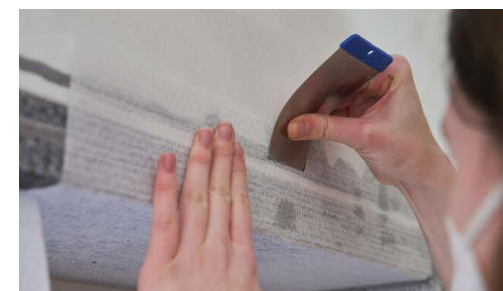
Abbildung 11: Tapete umklappen und mit einem Spachtel in die Kleberraupen einarbeiten.
