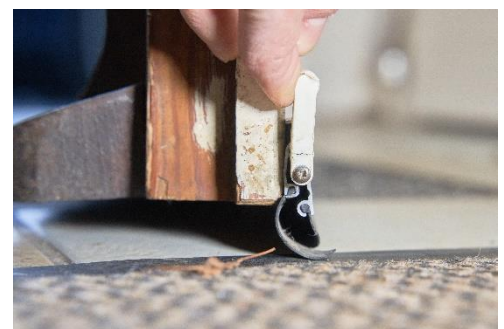
Abbildung 14: abgesenkte Absenkdichtung
