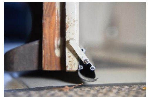
Abbildung 13: angehobene Absenkdichtung
