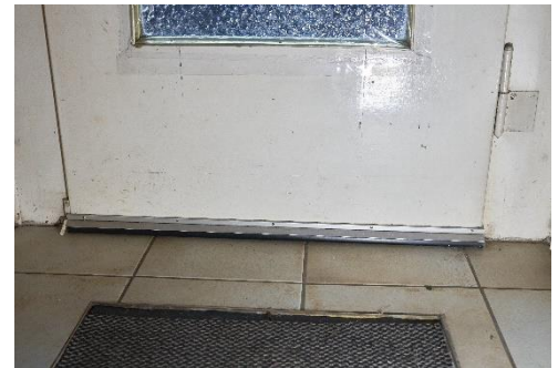
Abbildung 12: alte Eingangstür mit nachgerüsteter Absenkdichtung
