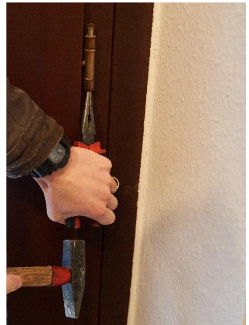
Abbildung 9: Ausrücken des Bolzens aus den Angeln
