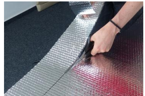
Abbildung 5: Folie schneiden.
