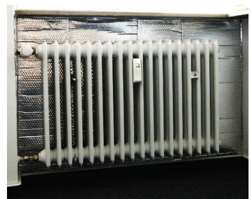
Abbildung 11: Die 2. Schicht ist aufgeklebt.
