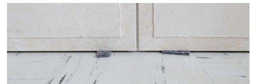
Abbildung 7: Platten auf Distanzstücke stellen
