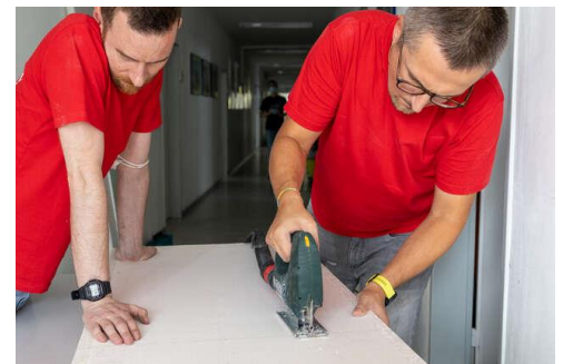
Abbildung 9: Platten bei Bedarf zuschneiden
