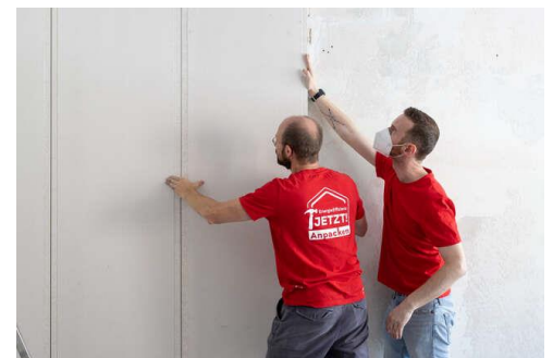
Abbildung 1: Innendämmung mit Verbundplatte aus Polyurethan-Hochleistungsdämmstoff und Silikatplatte
