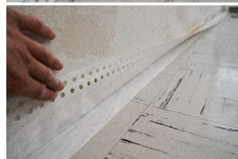
Abbildung 5: Luftdichte Verklebung der Fuge zwischen Mauerwerk und Estrich mit einem diffusionsoffenen Klebeband
