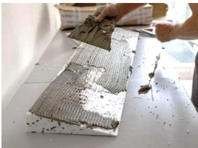
Abbildung 15: Anbringen der Flankendämmung
