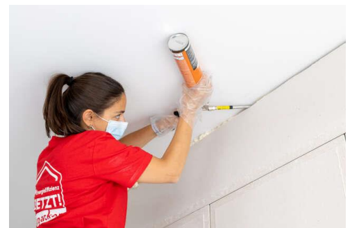
Abbildung 11: Oberste Platte setzen
