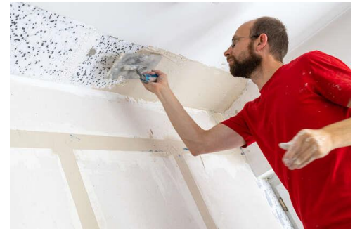
Abbildung 16: Spachteln der Flankendämmung
