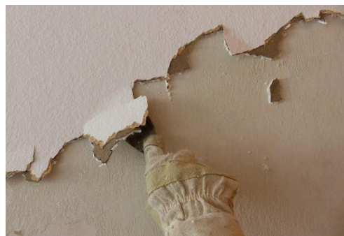
Abbildung 3: Entfernen der alten Tapete
