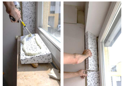
Abbildung 14: Anbringen der Laibungsdämmung
