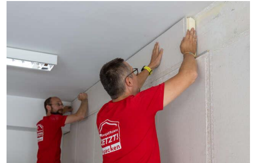
Abbildung 11: Oberste Platte setzen
