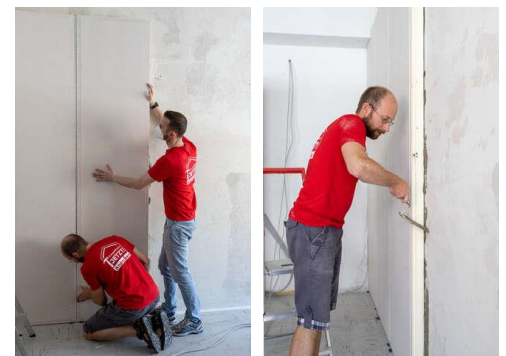
Abbildung 8: Platten setzen und überschüssigen Kleber wegnehmen
