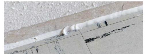
Abbildung 12: Fugen ausschäumen und mit Acryl abziehen (Distanzstücke vorher entfernen)
