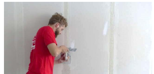
Abbildung 13: Fugen verspachteln
