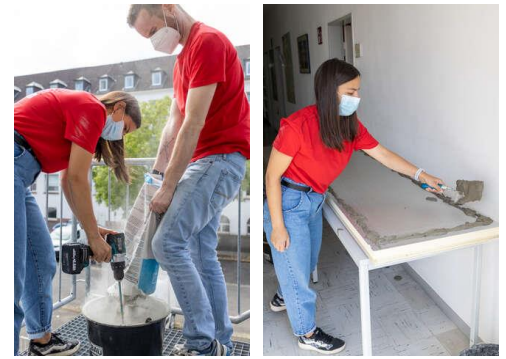
Abbildung 6: Kleber mischen und auftragen
