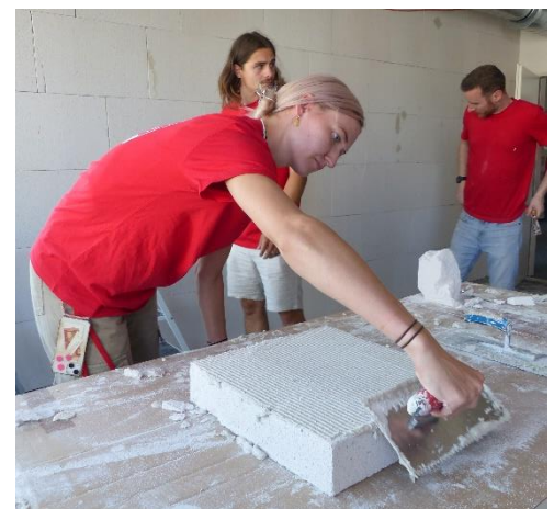
Abbildung 1: Innendämmung mit Mineralschaumplatten und Kalkmörtel
