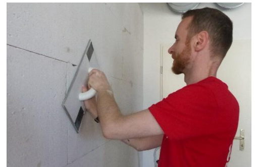
Abbildung 13: Glätten von Ecken und Kanten mit dem Schleifbrett
