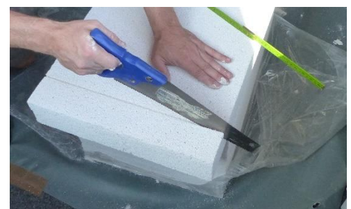
Abbildung 10: Zuschneiden der Platte mit der Handsäge
