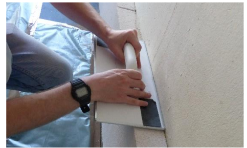
Abbildung 11: Glätten der Platten vor dem Aufsetzen der nächsten Reihe
