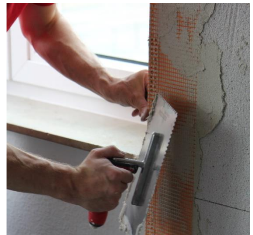
Abbildung 16: Eckleisten setzen
