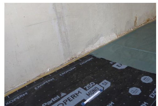
Abbildung 5: Fußboden und Möbel gut gegen Staub und Dreck abdecken
