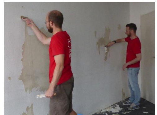
Abbildung 3: Entfernen der alten Tapete, falls nötig nach vorherigen Anfeuchten, beispielsweise mit einem Pinsel
