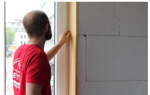
Abbildung 12: Anbringen der Laibungsplatten
