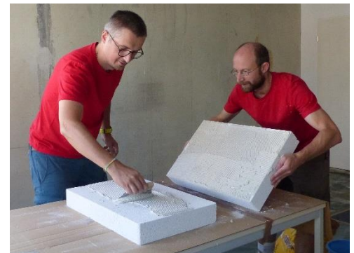
Abbildung 8: Einstreichen der Platten mit dem Zahnpachtel oder der gezahnten Glättkelle
