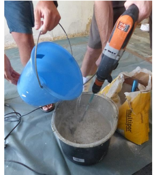
Abbildung 7: Anmischen des Mörtels
