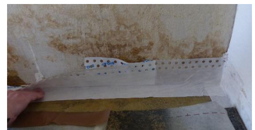
Abbildung 6: Luftdichte Verklebung der Fuge zwischen Mauerwerk und Estrich mit einem diffusionsoffenen Klebeband – Das Band muss sorgfältig an Boden und Wand angedrückt werden.
