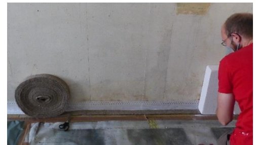
Abbildung 9: Setzen der ersten Platte auf dem Filzstreifen
