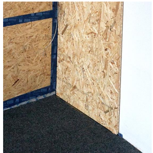
Abbildung 25: OSB verkleidete Flankendämmung
