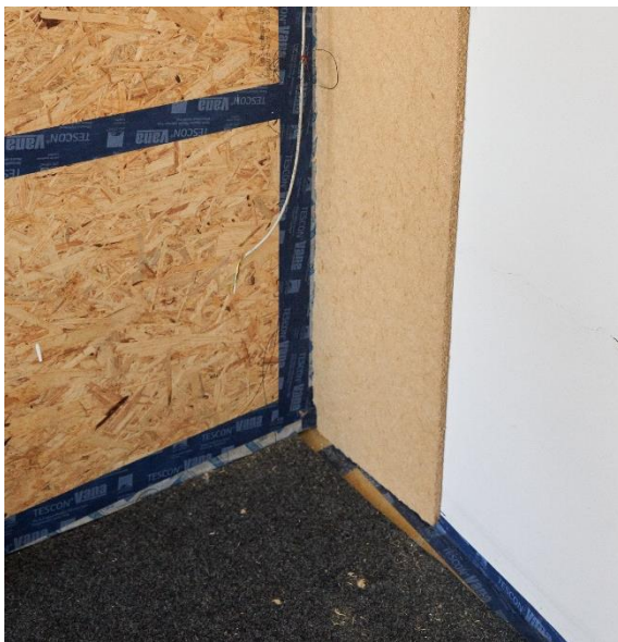
Abbildung 26: Angeklebte Dämmstoffkeile
