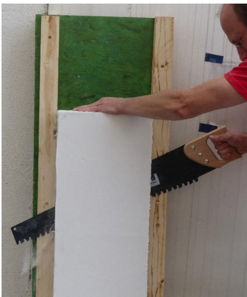
Abbildung 11: Sägen der Dämmstoffkeile
