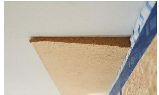
Abbildung 1: Dämmstoffkeil als Flankendämmung einer Innendämmung
