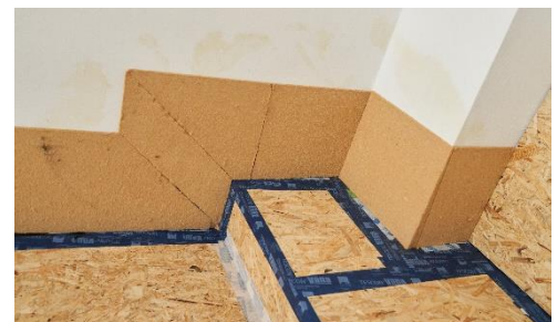
Abbildung 22: Anschluss der Flankendämmung im Eckbereich an die Flankendämmung der Wand
