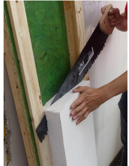
Abbildung 8: Sägen der Dämmstoffkeile
