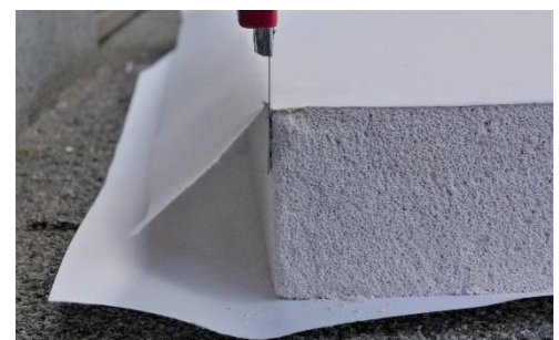
Abbildung 5: Abschneiden der überstehenden Renoviertapete
