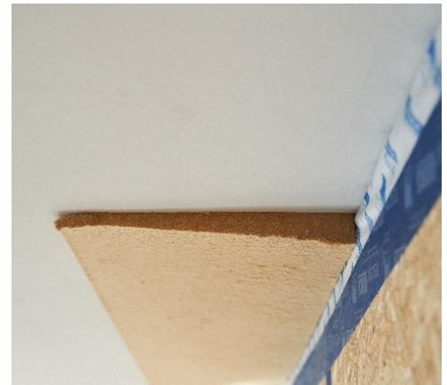
Abbildung 32: angebrachte Dämmstoffkeile als Flankendämmung
