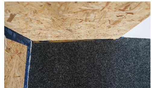
Abbildung 24: Angeklebte Dämmstoffkeile
