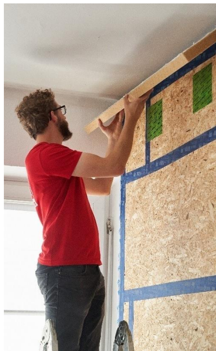
Abbildung 18: Ankleben der Flankendämmung (hier als ganze Platten statt in Keilform)
