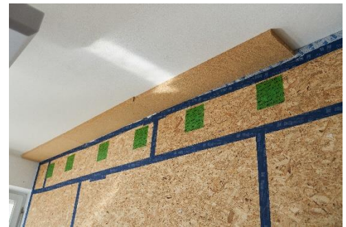
Abbildung 19: An der Decke angeklebte Dämmstoffplatten als Flankendämmung
