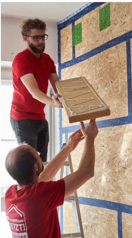
Abbildung 18: Ankleben der Flankendämmung (hier als ganze Platten statt in Keilform)
