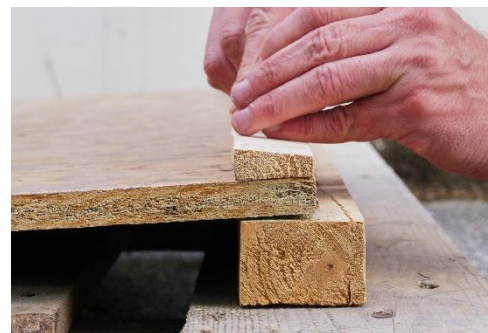
Abbildung 27: Ausrichten der zurechtgeschnittenen Holzquerschnitte
