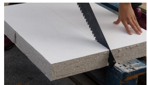
Abbildung 6: Zurechtschneiden der Dämmplatte
