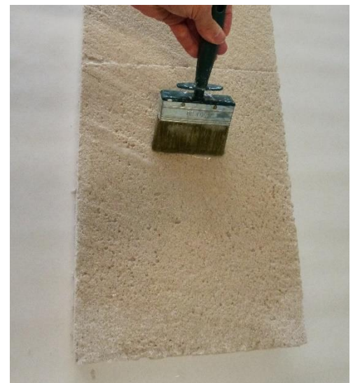
Abbildung 4: Einkleistern der Dämmstoffkeile
