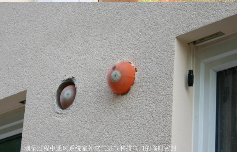
测量过程中通风系统室外空气进气和排气口的临时密封
