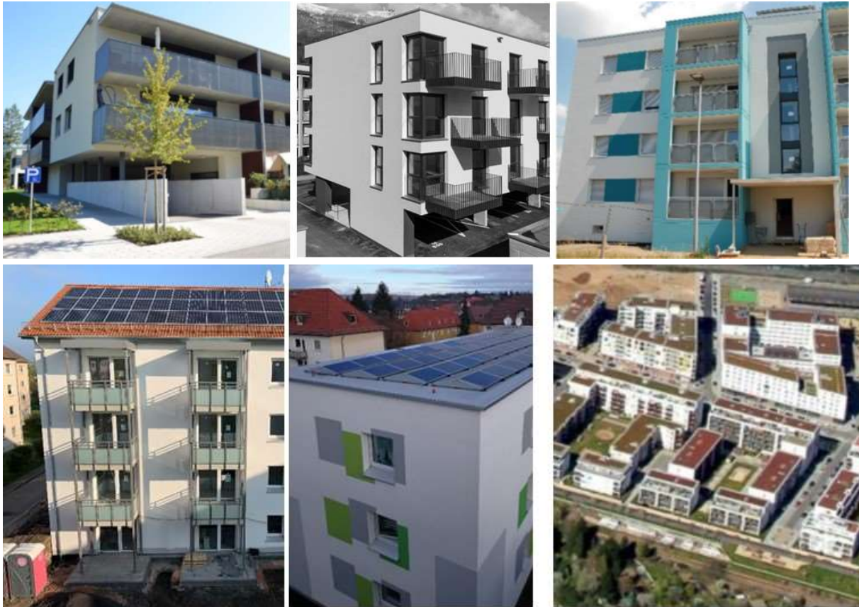
Abbildung 1: Beispiele für kostengünstigen und energieeffizienten Wohnbau: (von links oben) Modellvorhaben „KliNaWo“ in Feldkirch, Vorarlberg, VOGEWOSI / Energieinstitut Vorarlberg / 5-Euro-Wohnen, Schwaz, Neue Heimat Tirol / PassivhausSozialPlus, Darmstadt, Neue Wohnraumhilfe gGmbH / faktor10 GmbH / Fuldastraße 6 – 8 und Schwarzlachweg 42 – 44, Gießen, Wohnbau Gießen GmbH / Passivhaus-Stadtteil HD-Bahnstadt – Erfahrungen, Stadt Heidelberg
