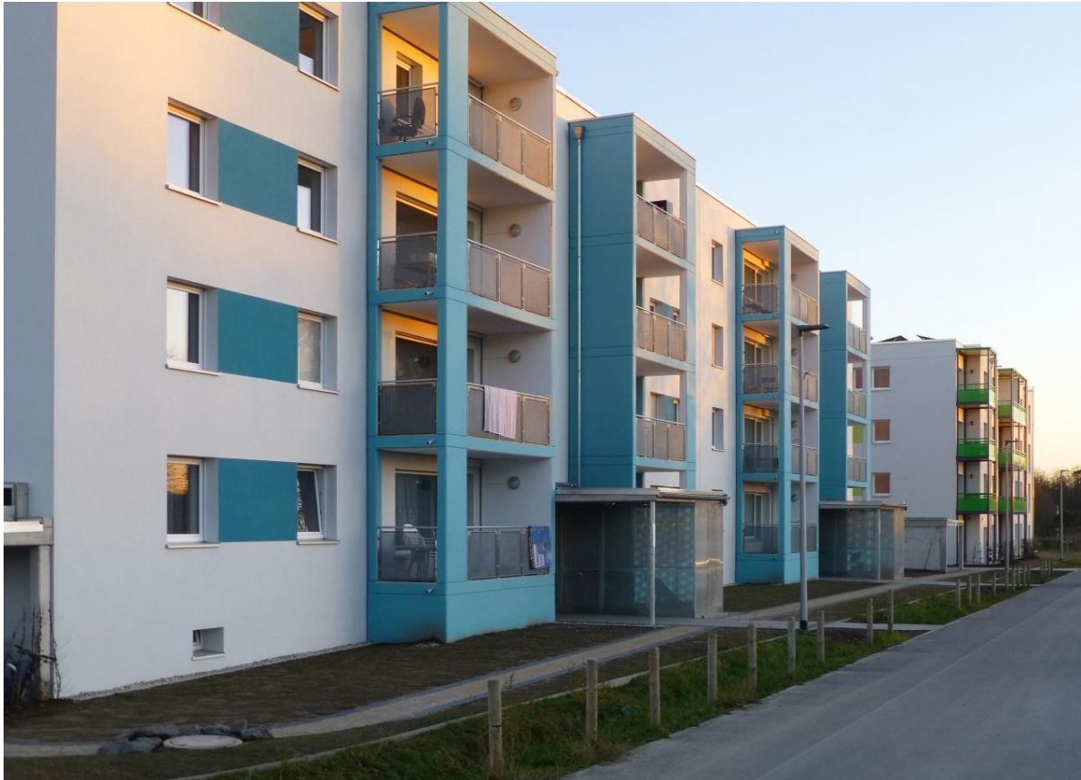
Abbildung 2: Westansicht des Bestandsgebäudes
