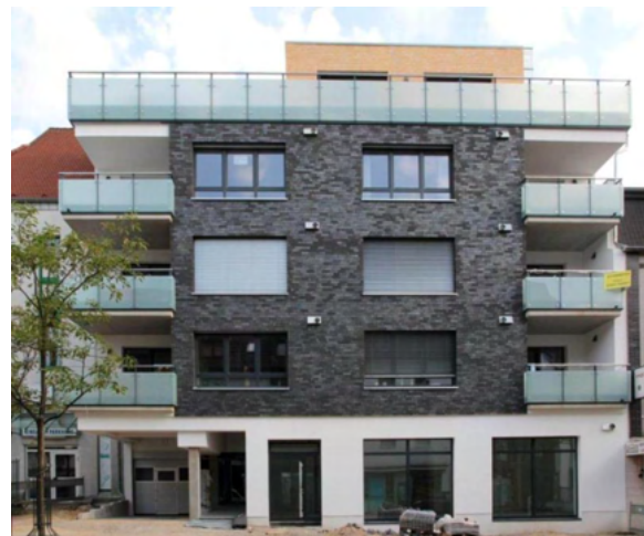
Abbildung 2: Fassade mit Putz und Riemchen, Wohn- und Geschäftshaus mit 11 Wohneinheiten. REPPCO Architekten 2013 (Projekt-ID2966)
