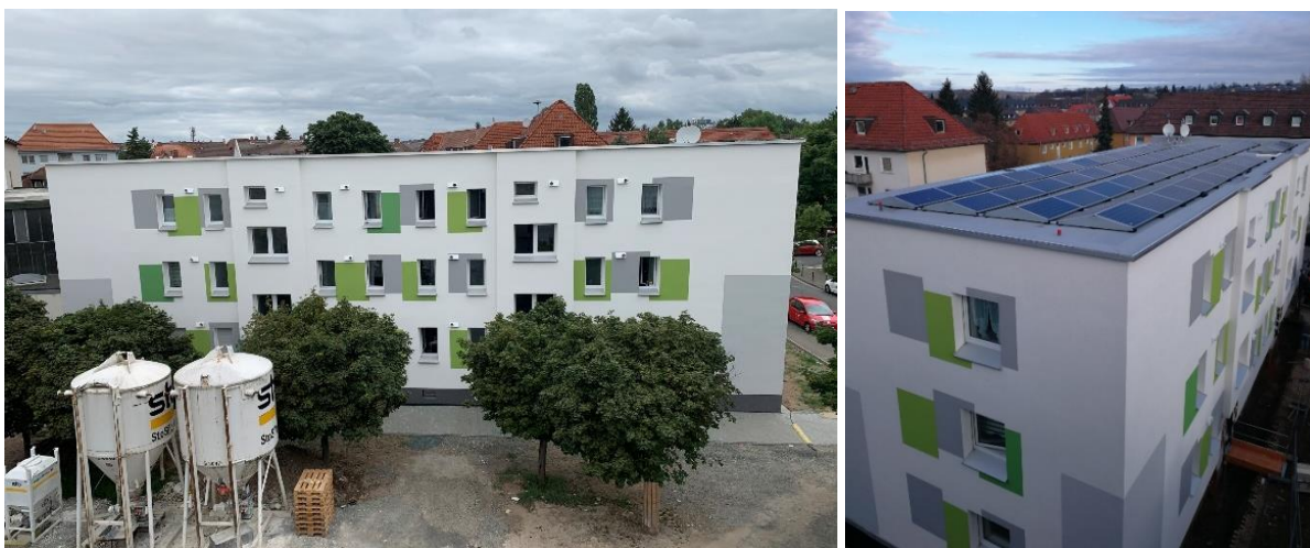
Abbildung 4 und 5: Flachdach nach der Sanierung mit Photovoltaikanlage
