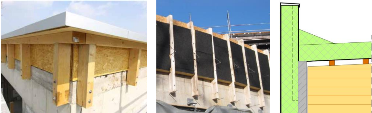
Abbildung 8: Attikaausbildung aus Holz und Holzwerkstoffen. Diese Lösungen können wärmebrückenfrei ausgeführt werden. Quelle: PHI.
