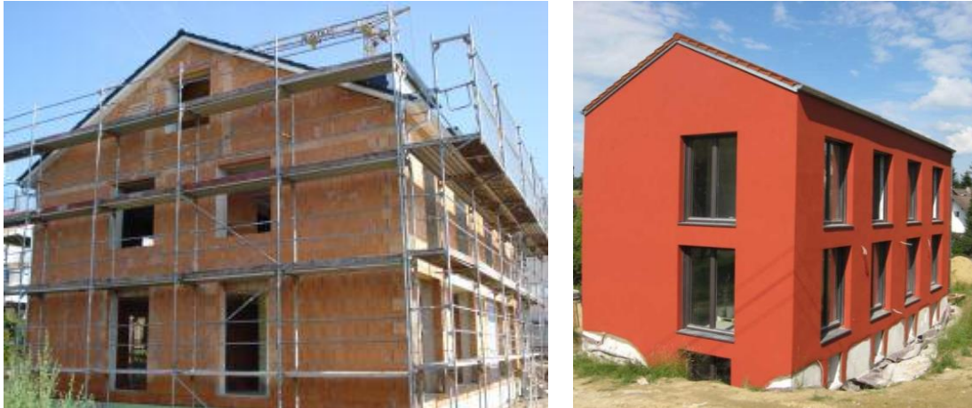
Abbildung 6: Wohngebäude in monolithischer Bauweise 1 .
