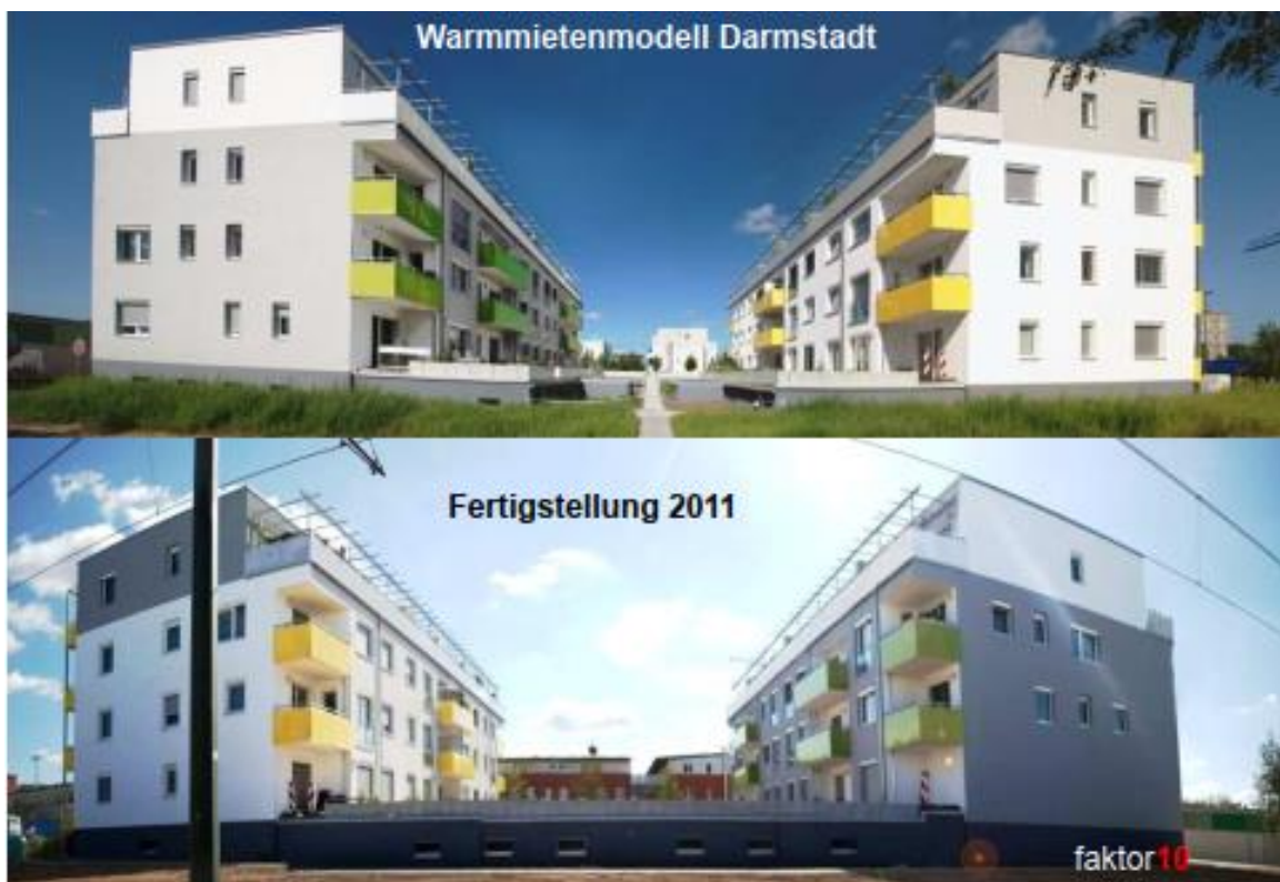
Abbildung 5: Ansichten des Projektes Warmmietenmodell in Darmstadt nach Fertigstellung
