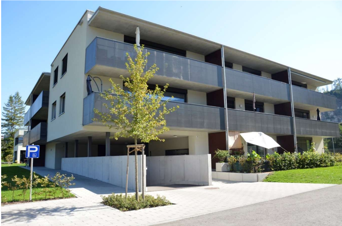
Abbildung 6: Foto des Ende 2017 fertiggestellten Gebäudes (Arch. Walser + Werle, Foto: Energieinstitut Vorarlberg)
