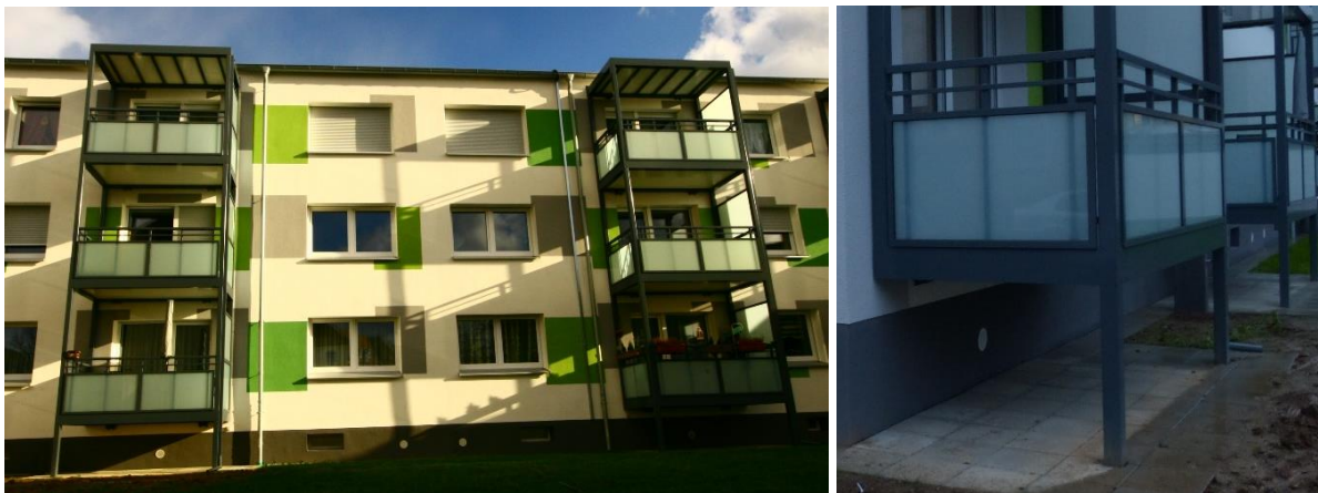
Abbildung 16: Projekt Wohnbau Gießen Schwarzlachweg
