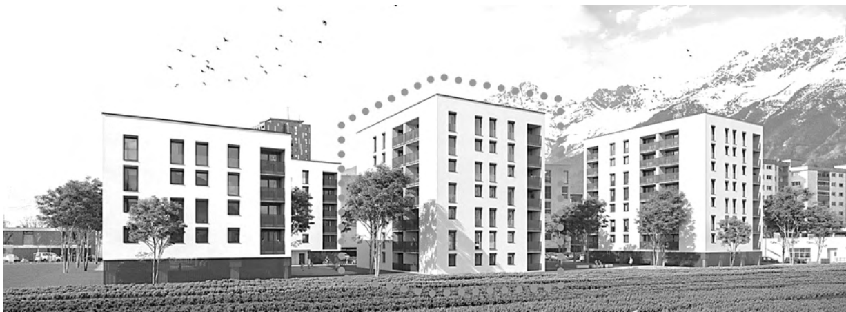
Abbildung 5: erstes 5-Euro-Passivhaus PLUS; gesamt 132 Wohnungen, davon 30 für 5-Euro-Wohnen
