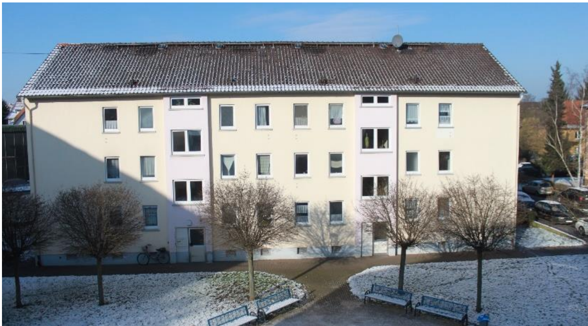
Abbildung 3: Satteldach im Bestand
