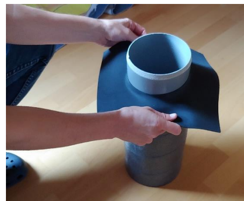
Abbildung 10: Aufstecken der Rohrmanschette
