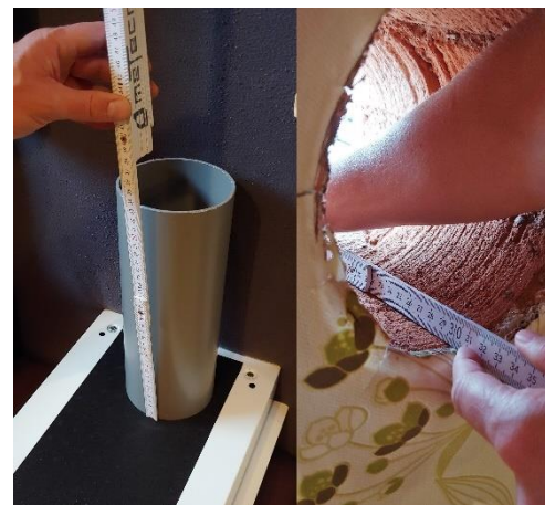
Abbildung 8: Ausmessen der Kernbohrungen
