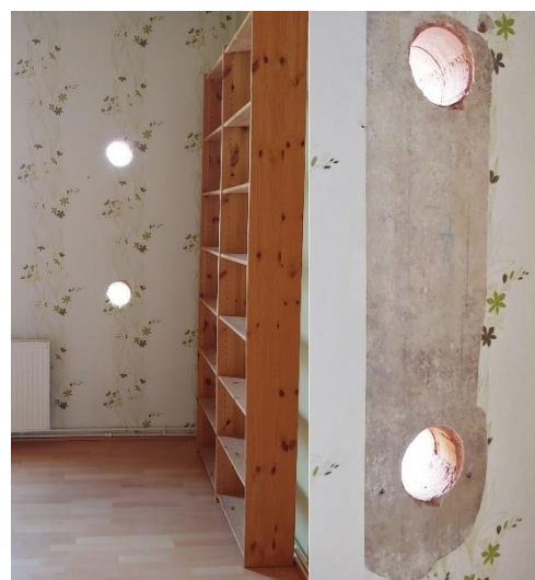
Abbildung 7: Durchgeführte Kernbohrungen für Außenluft- und Fortluftleitungen
