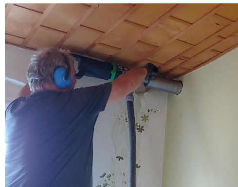
Abbildung 6: Durchführen der Kernbohrung
